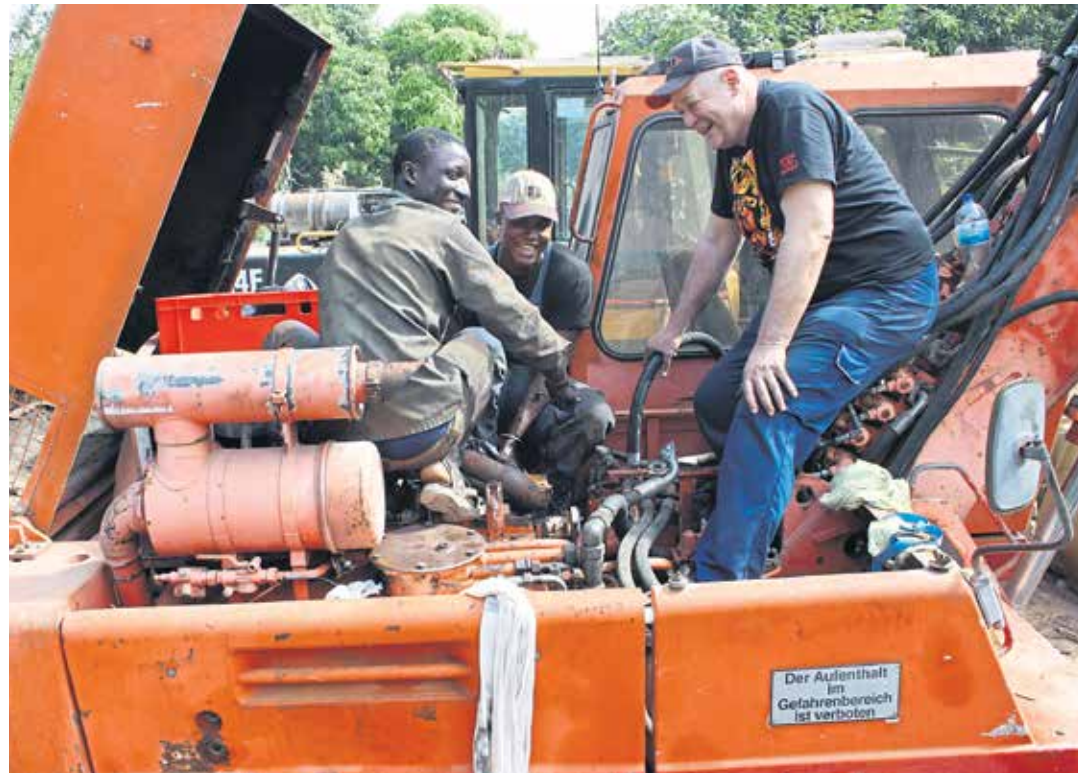
Zwei der afrikanischen Lehrlinge und Holger Wötzel (re.) reparieren den Bagger des DBO-Umweltprojektes.
